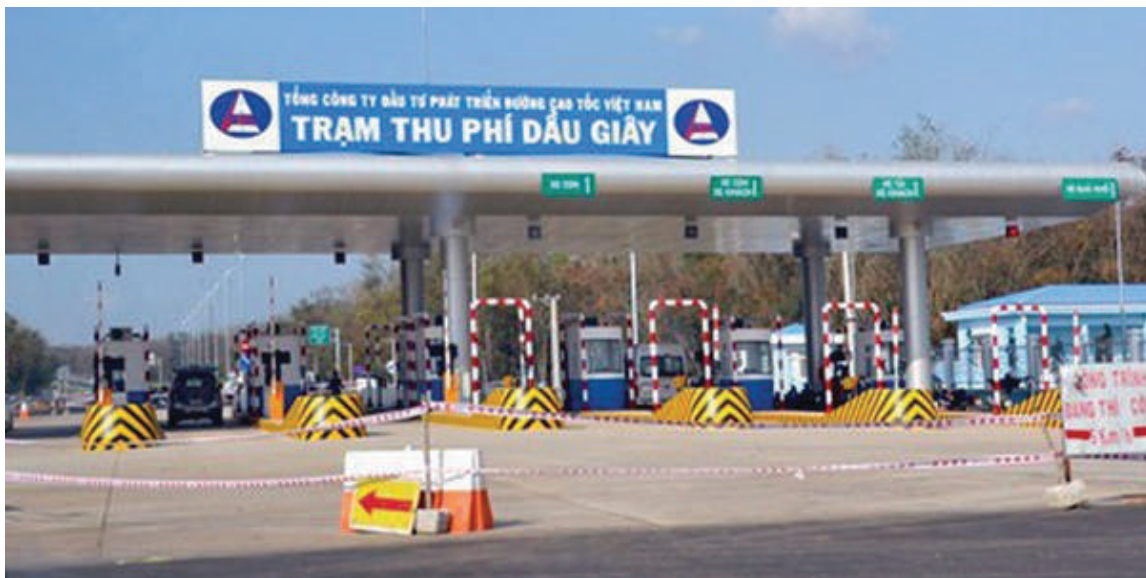
CÔNG TRÌNH HẠ TẦNG GIAO THÔNG
